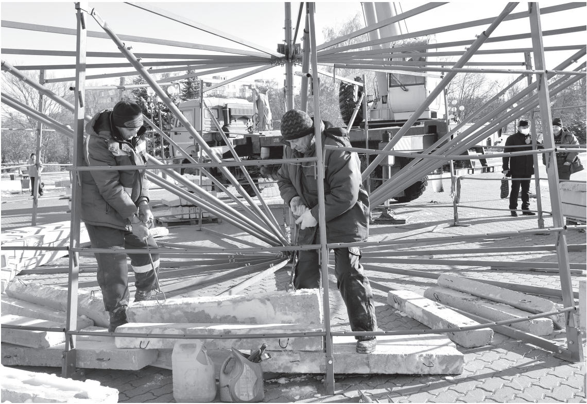
Роман Попов и Андрей Калинин монтируют пригрузки / ФОТО СВЕТАНЫ ПИВОВАРОВОЙ
