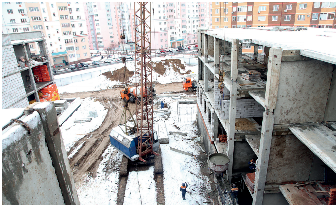
Ведётся бетонирование полов / ФОТО АВТОРА
