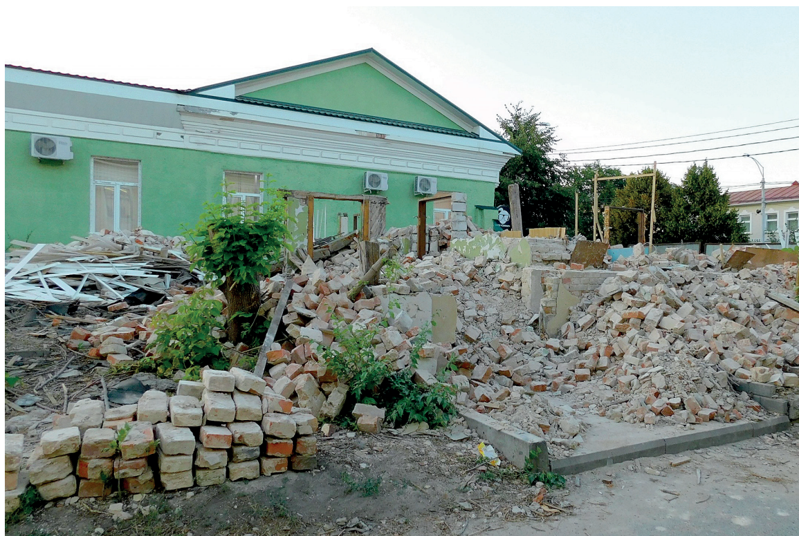
При попытке «зацепиться» за фундамент и несущие конструкции дом рассыпался / ФОТО ЕЛЕНА СВЕТЛОЙ
