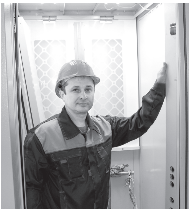
📍 Монтажник электрических подъёмников Дмитрий Нечаев / ФОТО СВЕТЛАНЫ ПИВОВАРОВОЙ
